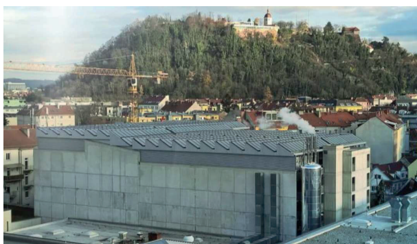
Figura 5-46 - Collettori solari per il raffrescamento degli edifici con chiller ad assorbimento. Graz, Austria 0.660 MWt.
