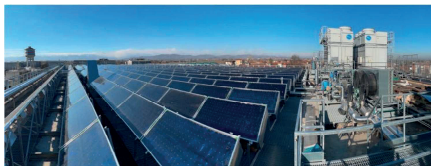
Figura 5-45 - Collettori solari per applicazioni industriali presso Martini e Rossi (Torino). L'impianto ha una potenza di 0.4MWt e utilizza particolari collettori sottovuoto di tipo piano. Foto TVP Solar, Svizzera
