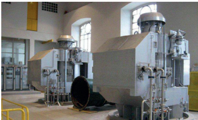
Figura 5-26 - Sala macchine con turbine Francis presso impianto TirrenoPower sul Fiume Roia presso Ventimiglia (IM)
